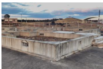
震災遺構の住宅基礎
